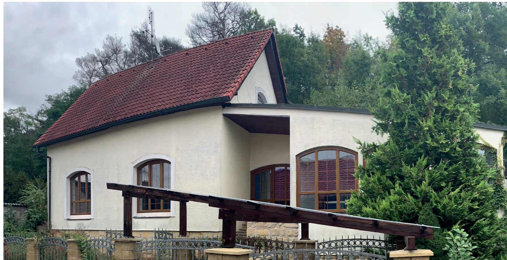
FOTO - STÁVAJÍCÍ STAV
