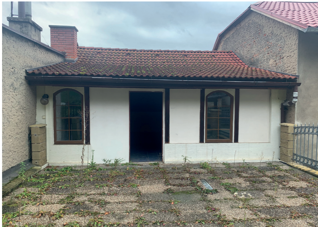
FOTO - STÁVAJÍCÍ STAV
